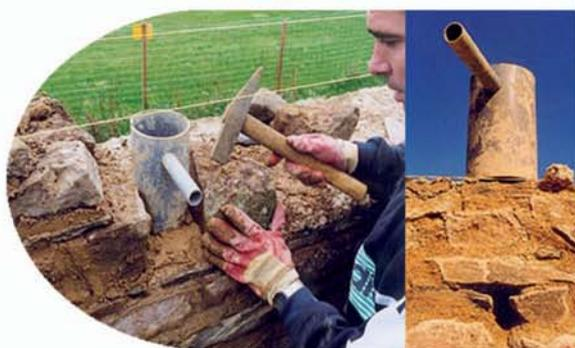
Insertion d'une cavité dans un mur à l'aide d'un gabarit, lors de la construction d'un mur. © M. Lomon - LPO Anjou
