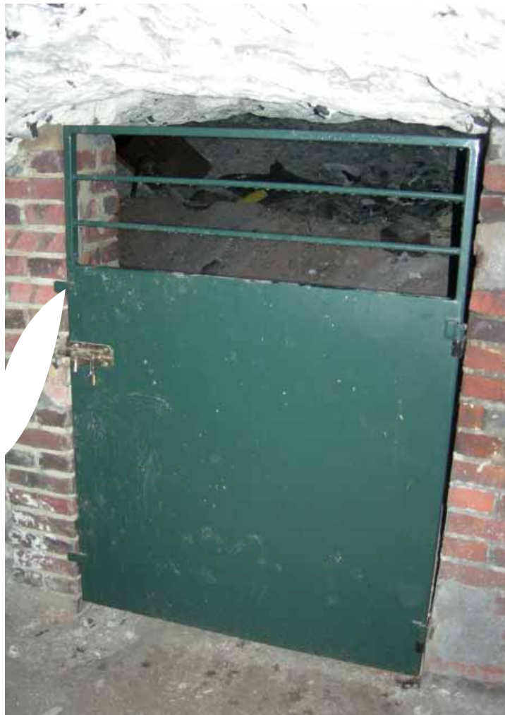
Porte aménagée de cave pour permettre la circulation des chauves souris.
