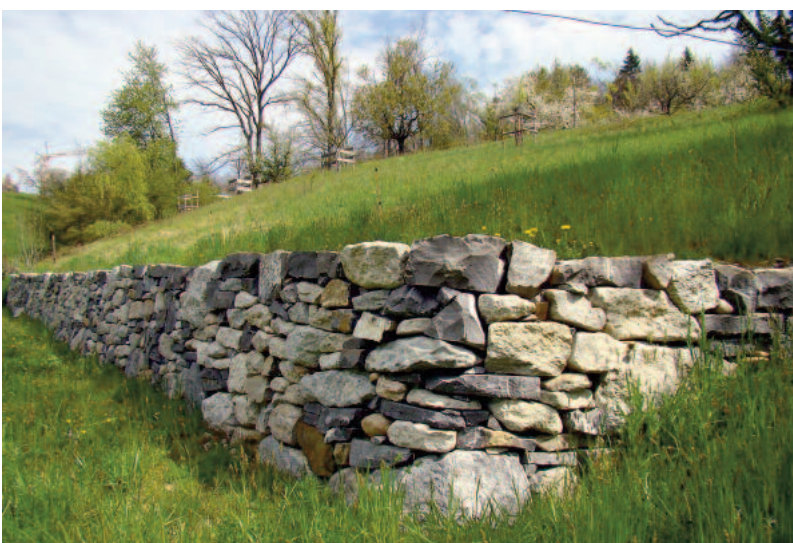
III. 18: Un mur en pierres naturelles construit dans une pente offre de nombreux abris.
