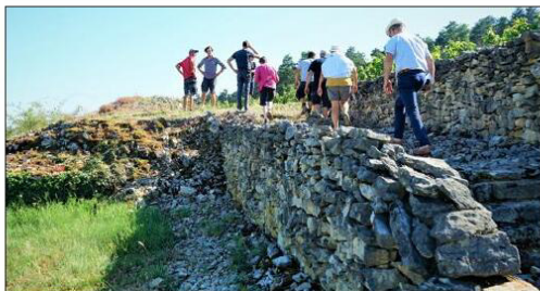
Ces murs, constitués uniquement de pierres, permettent de laisser circuler l'eau. Celui-ci a été réalisé par la technique de l'empilement, ce qui permet aussi de laisser sa place à la végétation et la biodiversité. Photo archives LBP/Emma BOSSAND
