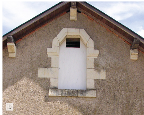
4- Chiroptière installée dans une toiture – B. Mème-Lafond 5- Ouverture permettant l'accès du comble aux chauves-souris – LPO Anjou
